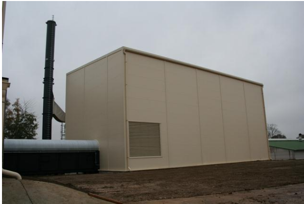
3. kép A 8MW teljesítményű, biomassza-tüzelésű hőközpont...
